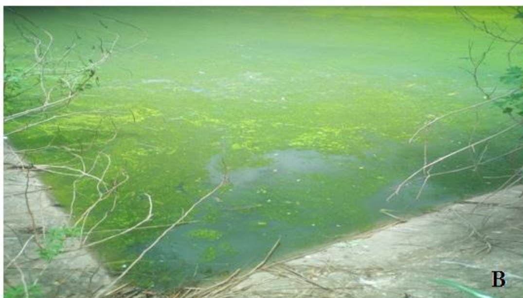
Photographie B : Bassin 3 de la station d'épuration avec la coloration verte de l'eau
