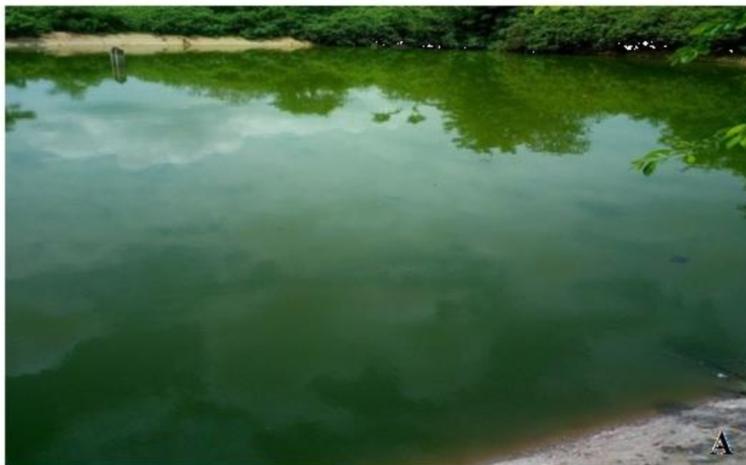
Photographie A : Bassin 1 de la station d'épuration avec la coloration verte de l'eau
